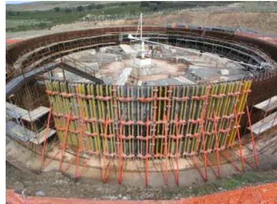
Fig. 2.2.d : Fondamenta, realizzazione. Ottobre 2004
