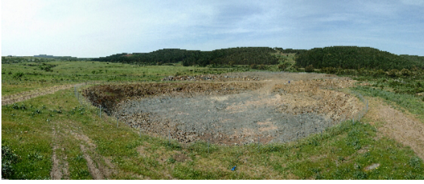
Fig. 2.2.a : Scavo di alloggiamento delle fondamenta
